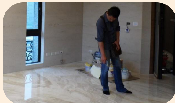
Step.7 地板鋪設完成後檢測及驗收
