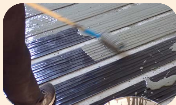
Step.5 彈泥封裝並靜置 3 天乾燥
