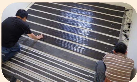
Step.3 鋪設電熱片
