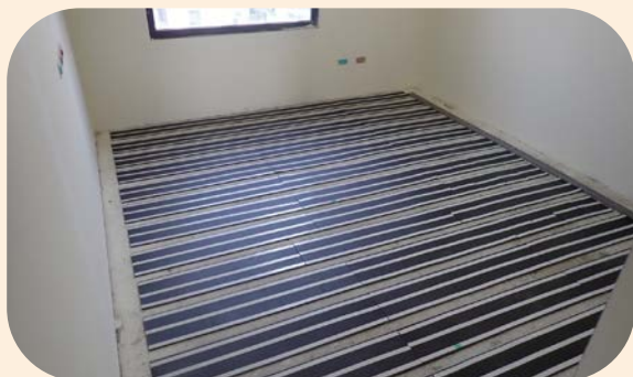
Step.2 鋪設斷熱 / 隔音層
